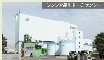
屋内型処理施設により、雨風や外気の影響を受けず、衛生的で安全な廃棄物処理を行っています。
