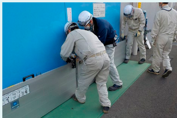
止水板の取り付け
