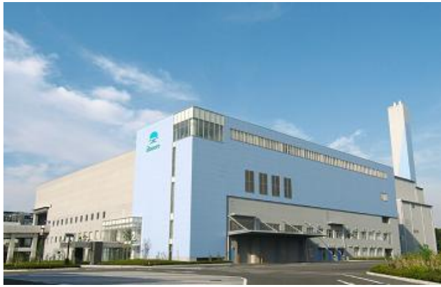
シンシア横浜 R・C センター（産業廃棄物処理施設）
