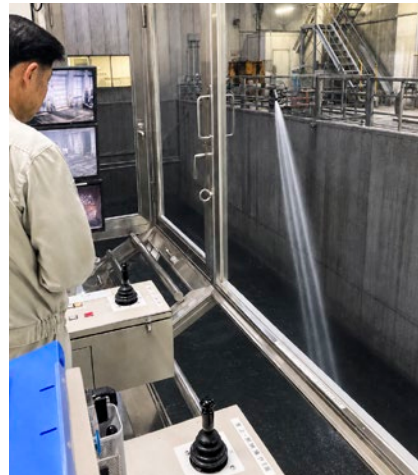
ピットへの放水訓練の様子
