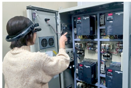
カメラに映る図面を見ながら配電盤のスイッチを確認
