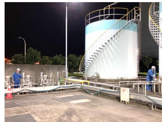
バルブ操作箇所の確認
